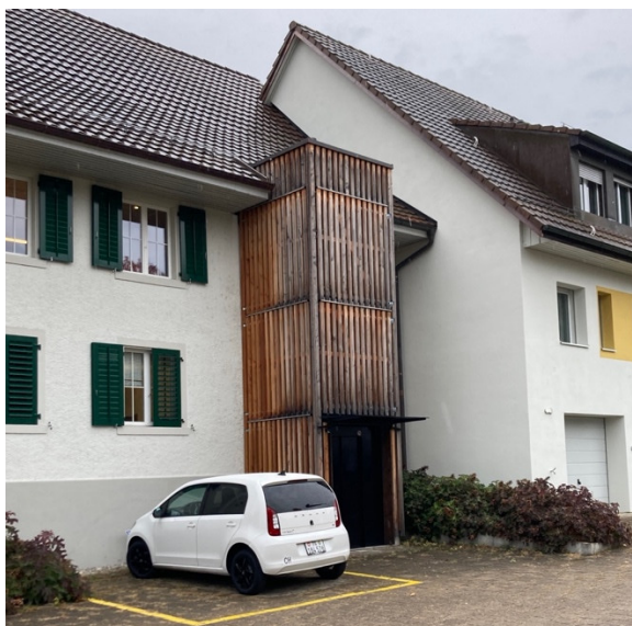
Beispiel eines nachträglich erstellten Liftanbaus in der Gemeinde Rorbas
