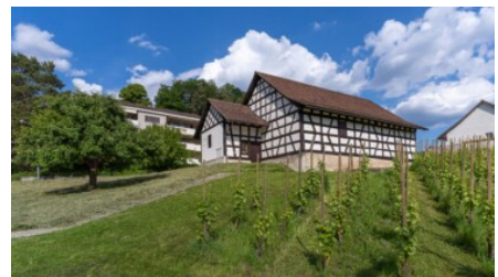
Trotte, Breitestrasse 17 in Freienstein
